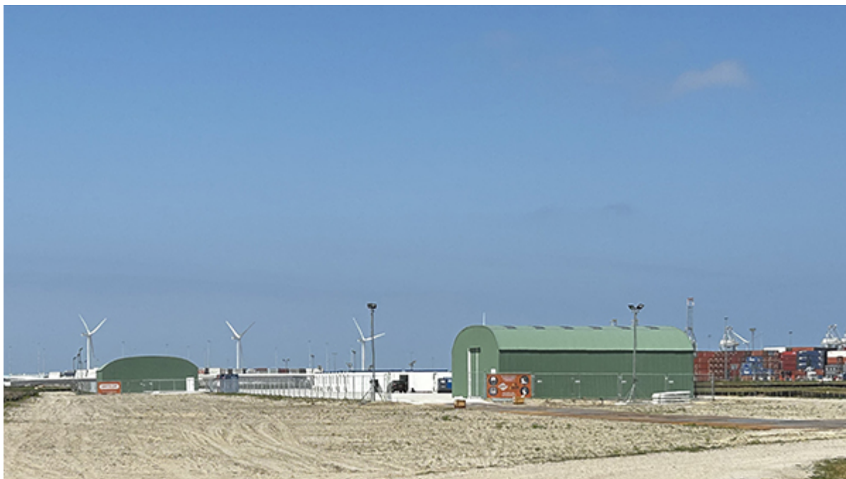
Ketenterrein in aanbouw
