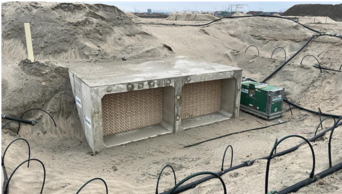
Ondergrondse constructie met schildmuren
