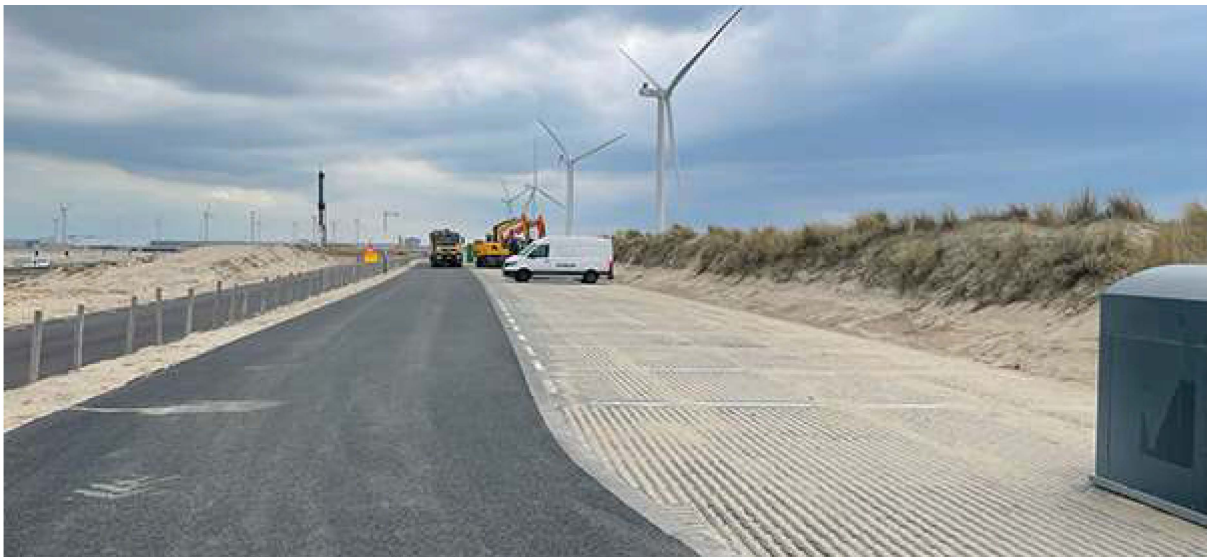
Nieuw aangelegde parkeerplaats P5
