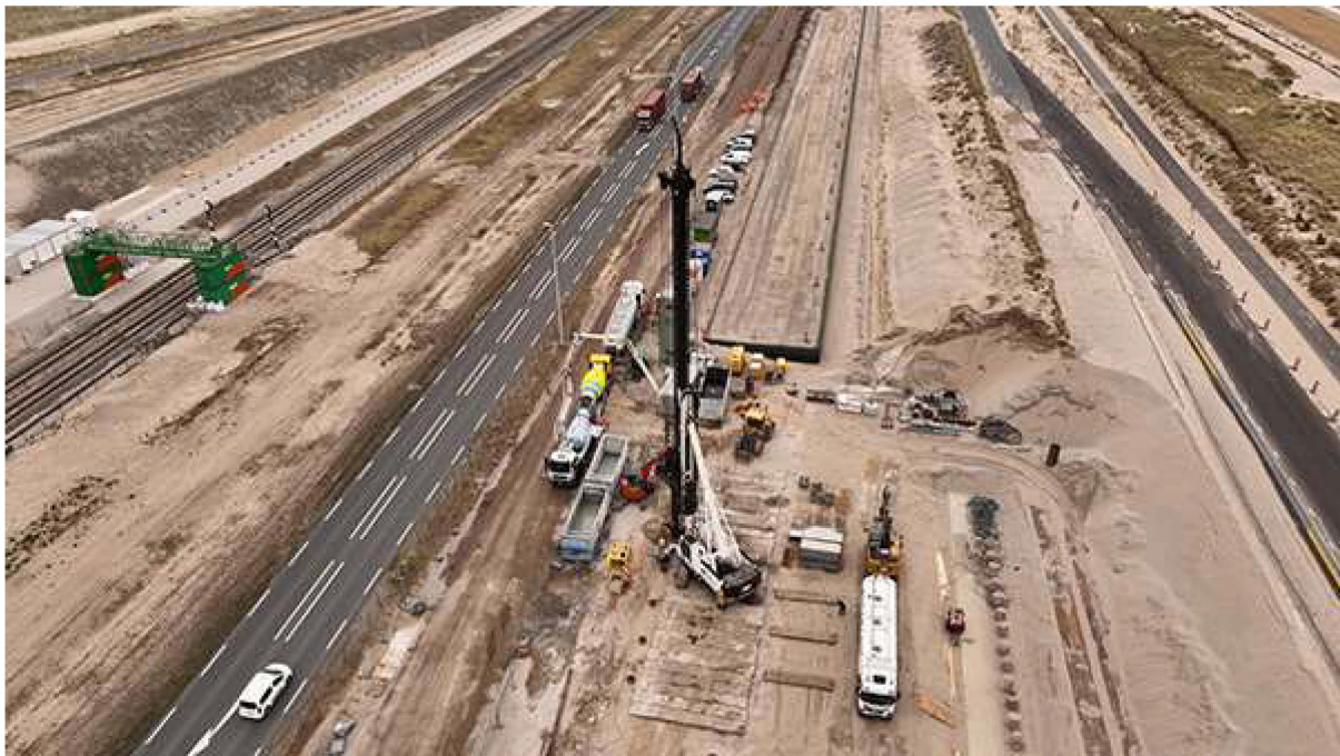
De voetgangersbrug over het spoor, in BAM-kleuren linksboven
