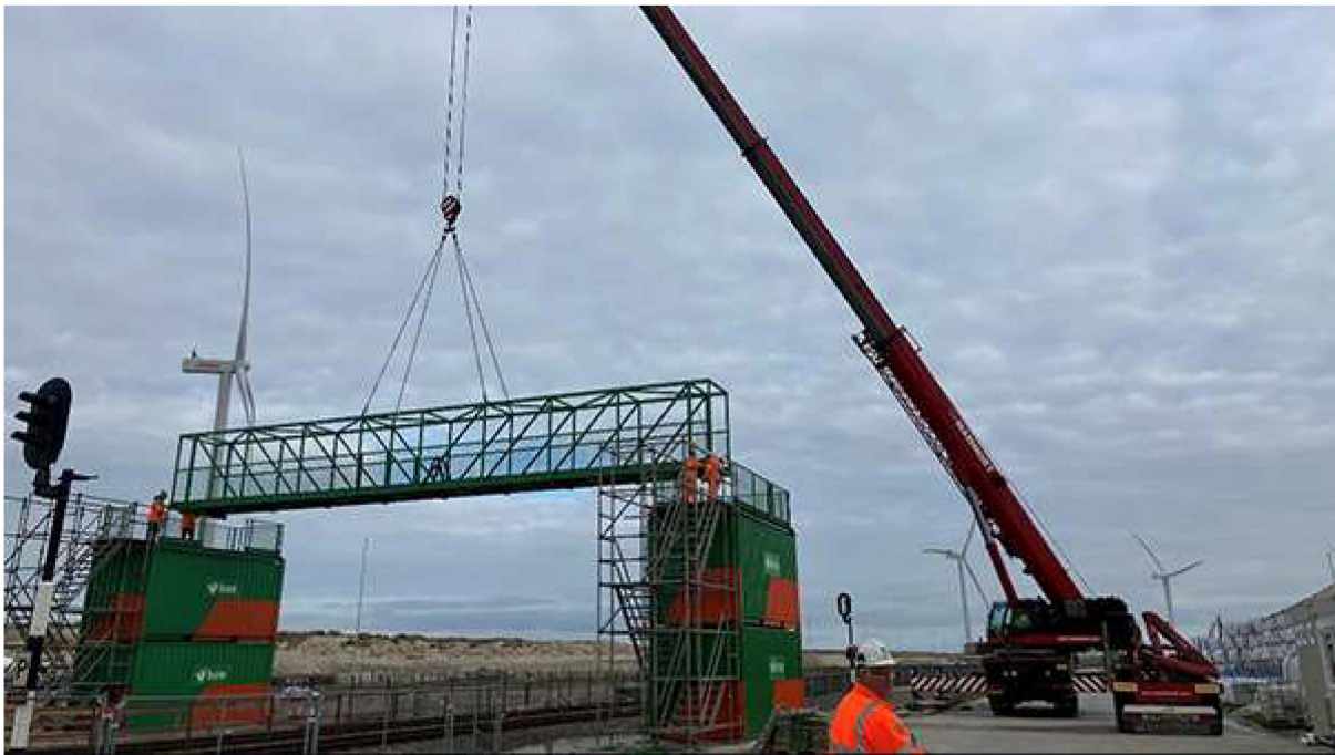
Het plaatsen van de voetgangersbrug over het spoor
